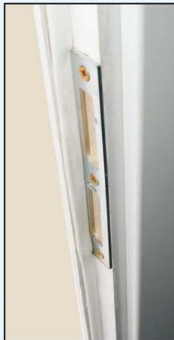
Detail osadenia protiplechu
