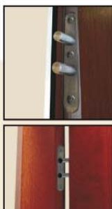
Čapy proti vysadeniu do drevoaluminickej zárubne
